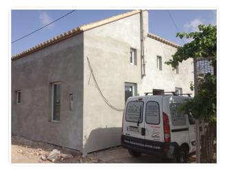
System), es un sistema EPS de aislamiento térmico y acústico de fachadas por el exterior. Mientras que otros aislantes se incorporan a la fachada mediante una obra, el Sistema SATE se trata de un panel de aislamiento prefabricado que se adhiere a las fachadas por fijación mixta (mediante fijación mecánica y adhesiva) por lo que dota a la fachada de una envolvente térmica que mejora la eficiencia energética y minimiza la fuga de calor y la entrada de
