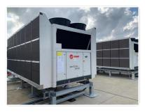
du système. Comme les compresseurs des machines de réfrigération de Trane sont situés dans la même armoire que les condenseurs, et que ce sont justement ces composants qui sont susceptibles de nécessiter un entretien, une passerelle a été créée entre le PreCooll et le condenseur à la demande de Trane. Cela permet d'accéder à tout moment au condenseur et aux compresseurs à des fins d'entretien.
