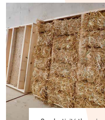
Isolation murale par bottes rectangulaires de 100 à 150 mm d'épaisseur
