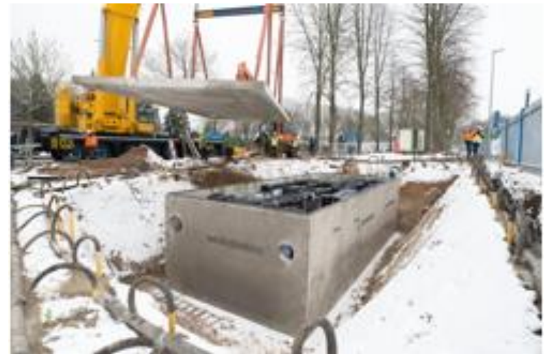
Bloc sous-station standardisé du projet Mijnwater
