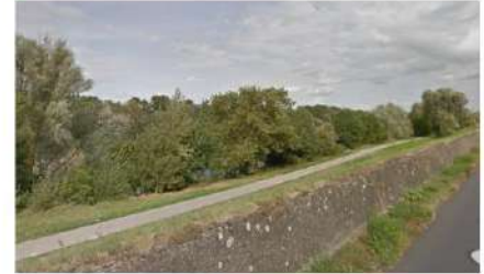
Les ouvrages en terre
