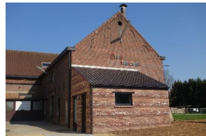
Pavillon de sanitaires du Chiro d'Itterbeek (Dilbeek) – Projet belge ©Rotor asbl-vzw
