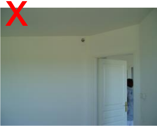
Bouche d'insufflation mal positionnée
