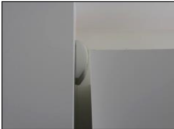
Bouche d'insufflation mal positionnée
