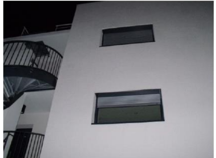
escalier côté façade Sud
