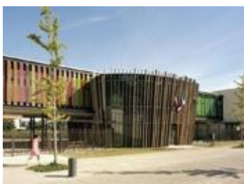
Lauréat "Confort & Santé" Groupe scolaire Simone Veil (France)
