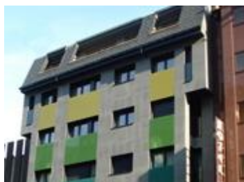
Lauréat "Rénovation Energétique" Aconcagua
