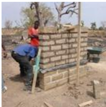
Artisans construisant un mur à Ouagadougou
