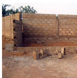
Construction en béton
