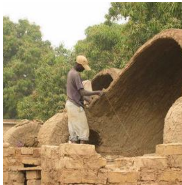
Construction d'une voûte
