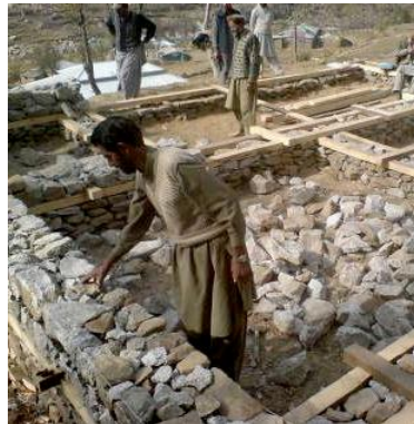
Construction des maisons
