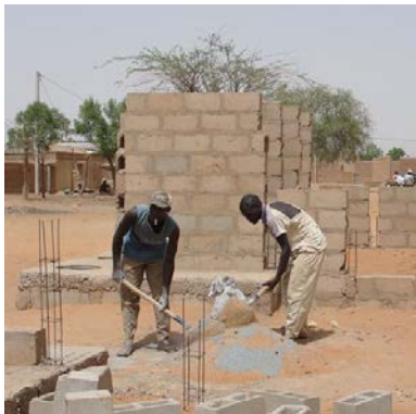
Construction d'infrastructures sanitaires
