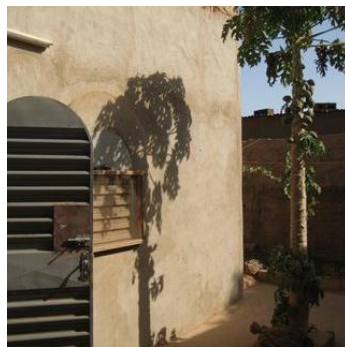
Maison en terre à Ouagadougou
