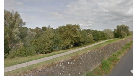
Les ouvrages en terre
