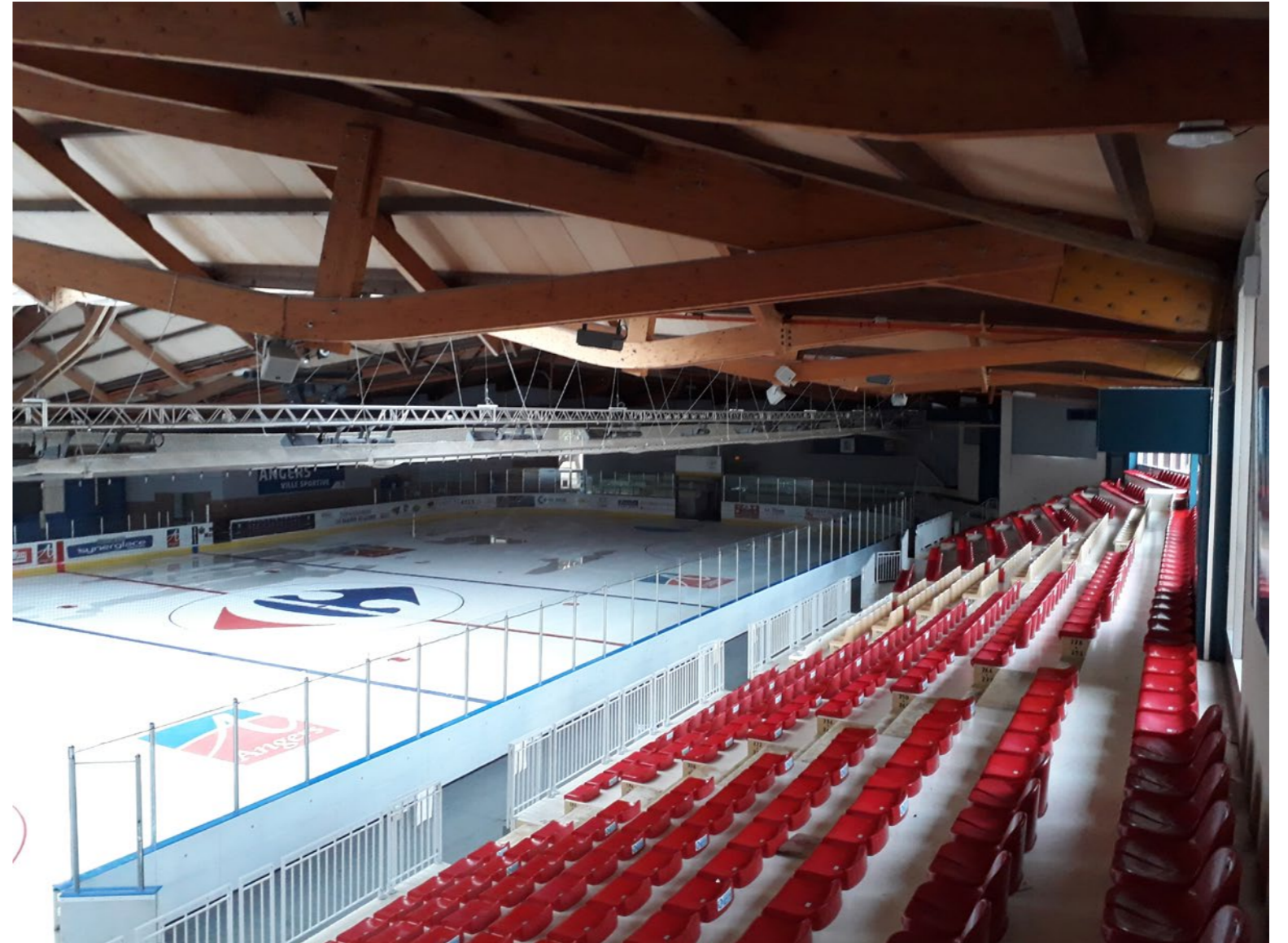
Poutres cintrées Patinoire du Haras / Ville d'Angers
