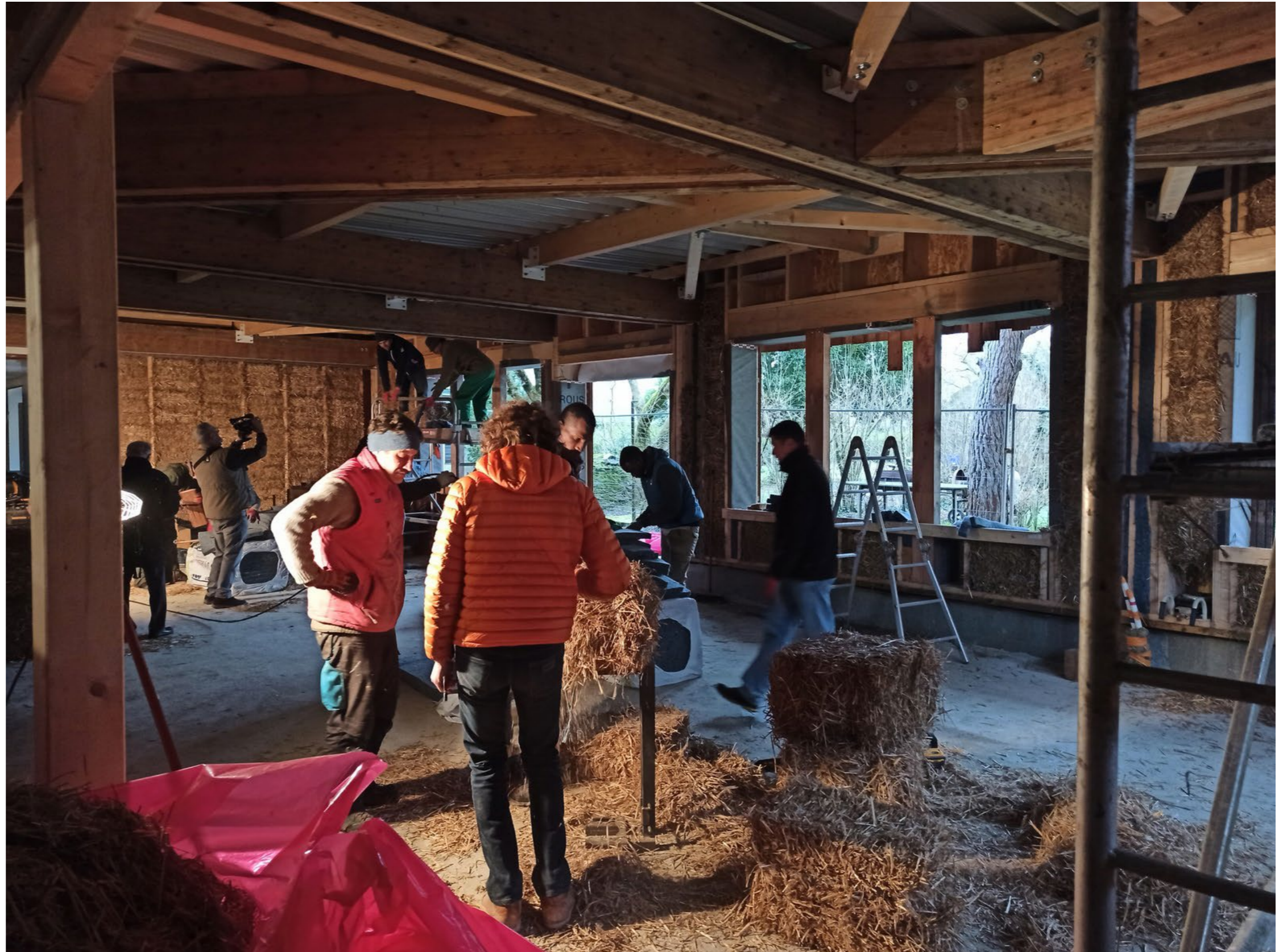
Chantier participatif de mise en oeuvre des bottes de paille
