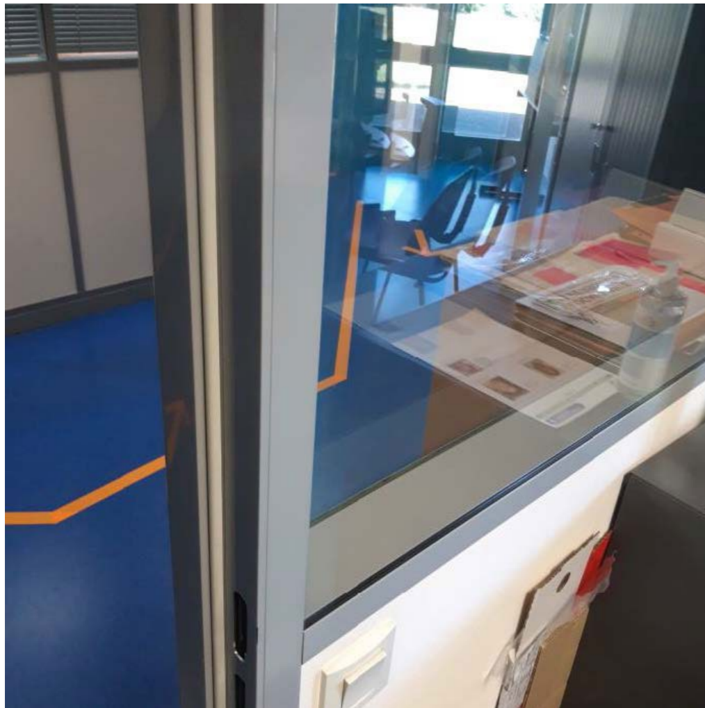
Cloisons de bureau Espace Pierre Cointreau / CCI
