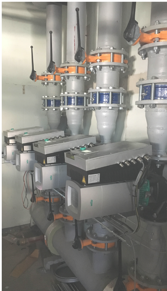
Cascade de quatre pompes Wilo-Stratos GIGA
