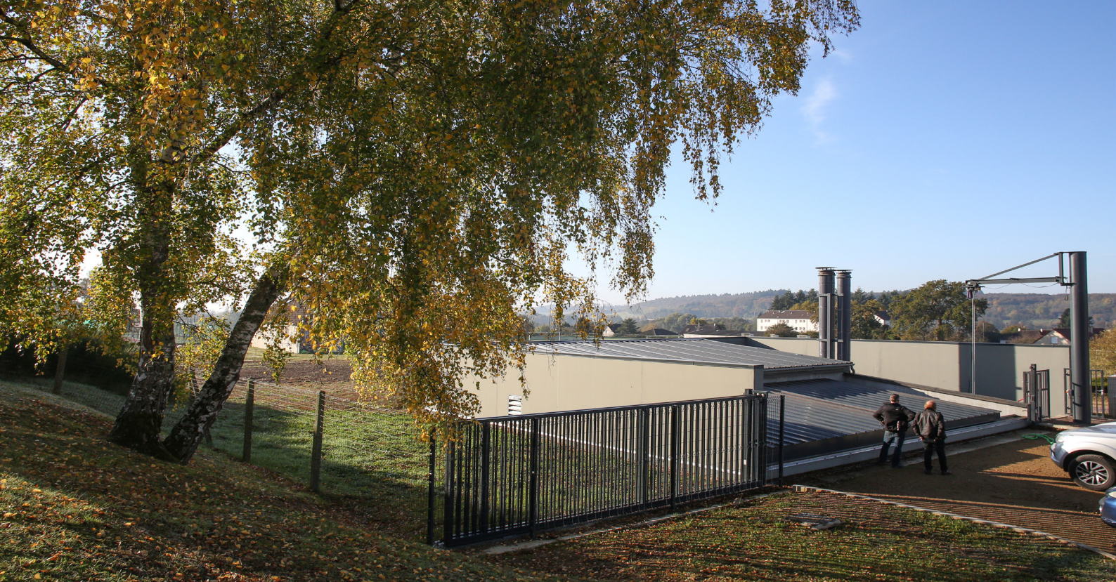
Chaufferie biomasse d'Urzy.
