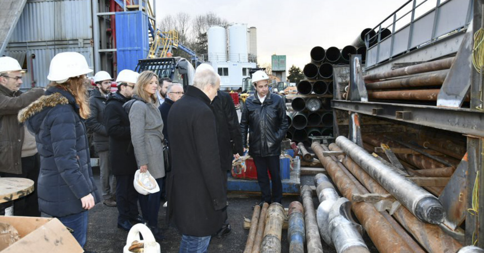
Les élus du SIPPAREC en visite de chantier de forage géothermique pour le réseau de chaleur des villes de Bobigny et Drancy.
