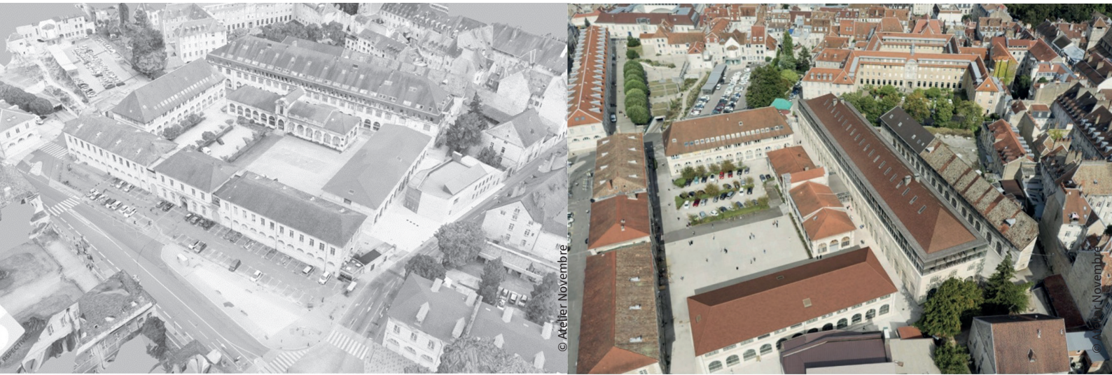
Réhabilitation du site de l'Arsenal (Rectorat de Besançon)
