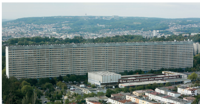
Le chantier du Plateau de la Haye : 60 millions d'euros (dont 600.000 € pour le lot « dépose et remise en état » attribué à l'entreprise d'insertion Réciprocité) et 5 ans de travaux. 1500 robinetteries, 650 baignoires, 1600 châssis PVC, 4km de gardes corps, 800 WC, 800 lavabos, 1000 boîtes à lettres, 5000 disjoncteurs, etc.
