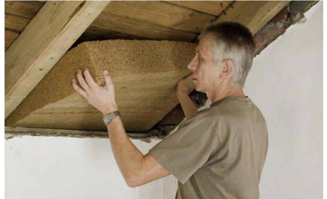
*Les matériaux respirants et perméables à la vapeur d'eau, tels que les isolants en fibres naturelles, contribuent à réguler l'humidité et à améliorer la qualité de l'air intérieur.*
