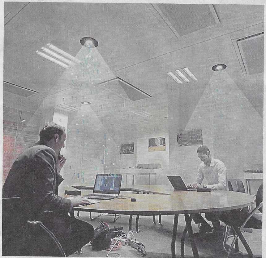
L'éclairage à base de LED permet de transmettre des données à un débit équivalent à celui du wi-fi. Photo Lucibel
