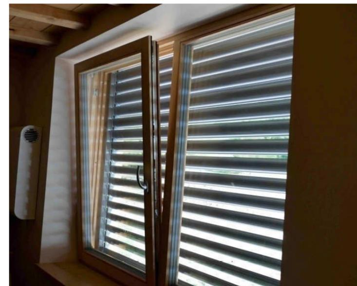
Figure 35 : Aération nocturne par ouverture oscillante
