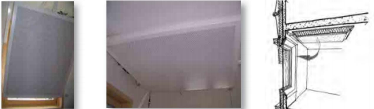
*Une augmentation de la surface vitrée à 22% par rapport à la surface de plancher a été rendue possible par la mise en œuvre de « bouchons thermiques » intérieurs et de brise-soleil extérieur orientable. Les « bouchons thermiques », qui comportent 9 cm de laine de verre, sont conçus pour être rabattus contre les fenêtres, en période d'inoccupation l'hiver, à l'aide d'une télécommande.*
