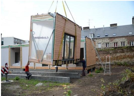
Illustration 3 : Installation sur les fondations et assemblage des modules
