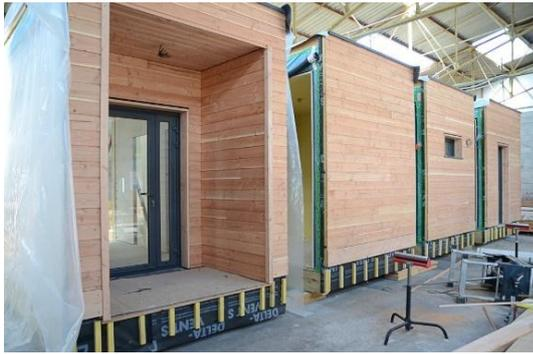
Illustration 1 : Préfabrication des modules en atelier
