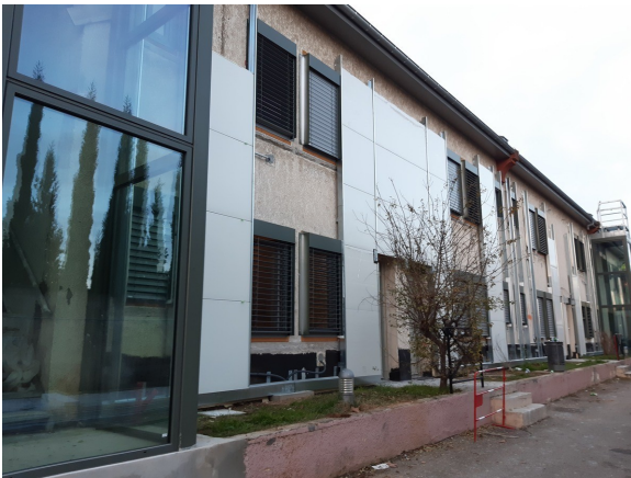
Panneaux d'isolation thermique extérieurs, résidence Les Résédas.
