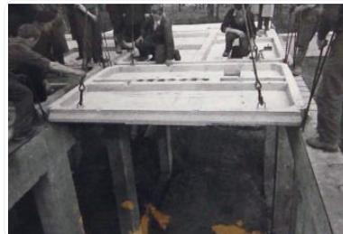
Les planchers sont constitués de deux demi-coques nervurées respectivement de 4 et 7cm d'épaisseur et de réseaux pré-assemblés et intégrés aux cloisons des logements. La combinaison de ces procédés a participé à l'optimisation du délai de construction.
