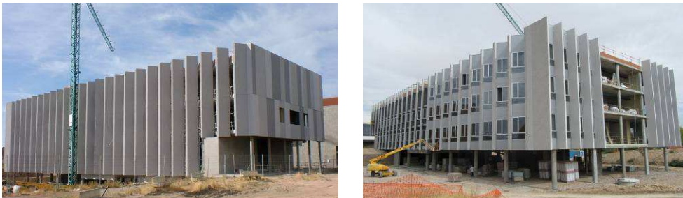
Figura 1. Estado de construcción del edificio en septiembre de 2012.
