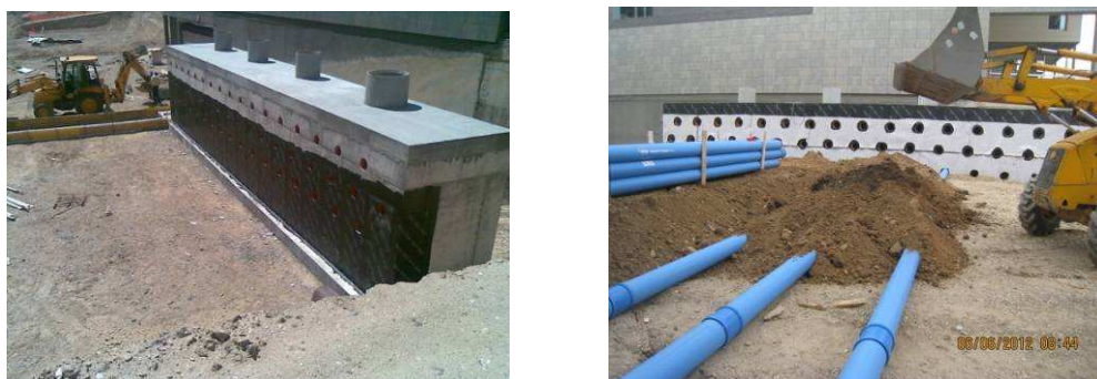
Figura 6: detalle de pozos geotérmicos (pozos canadienses) en construcción.
