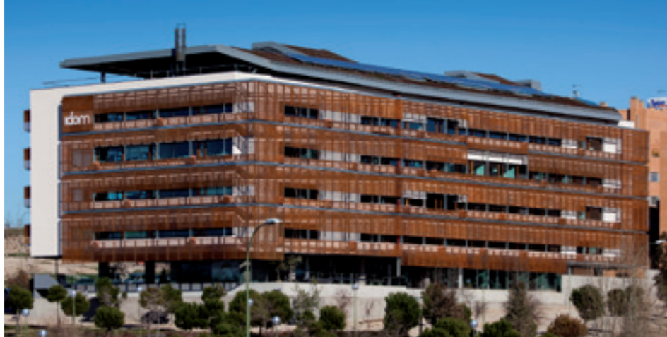
Edificio de IDOM en Madrid.
