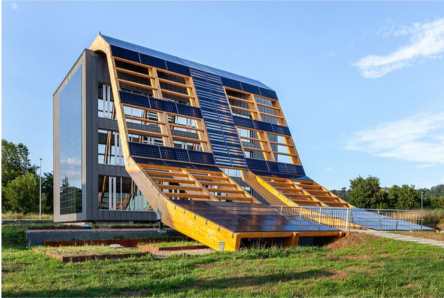
— La pérgola fotovoltaica en la fachada principal sur marca la entrada al edificio, con una doble función de filtro solar y captación energética.
