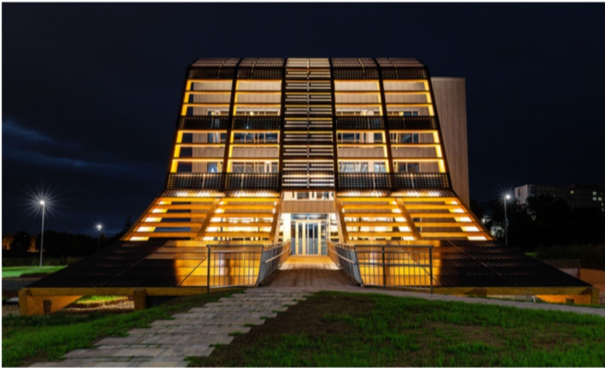
Vista de noche del exterior del edificio.
