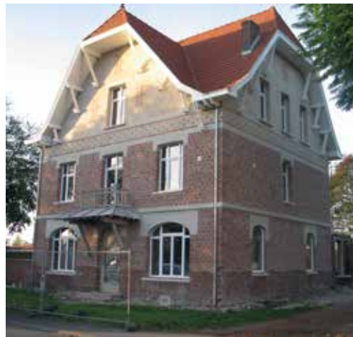
Cette belle maison a été rénovée par le cd2e dans le cadre du projet Réhafatur. Elle sert de démonstration pour montrer comment utiliser les écomatériaux en contexte de rénovation.
