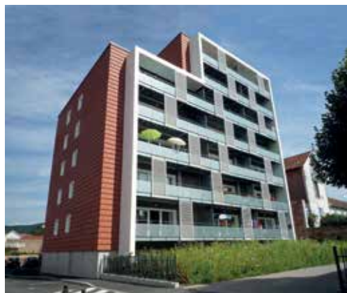
Le Toit Vosgien, un bâtiment en bois et en paille certifié Passivhaus. Avec ses huit étages en panneaux de bois lamellé-croisé (CLT), c'est le plus haut bâtiment français en bois. Sur le côté extérieur de ces panneaux sont fixées des caisses contenant chacune cinq bottes de paille de 38 cm de largeur. Source : Antoine Pagnoux
