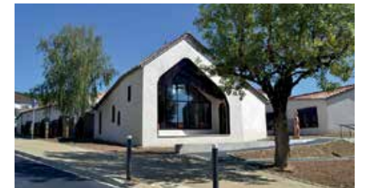
Gour de l'Arche, murs de façade en béton de chanvre Source : Dauphins-Architecture
