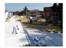
FSD 20 / PLUS-E/PRO 80 / PRO 170 TIPO/ ROOF SOIL/SEDUM/STABILFILTER SFE
