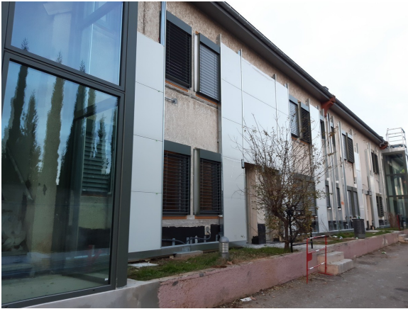
— Exterior thermal insulation panels, Les Résédas residence
