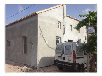
System), es un sistema EPS de aislamiento térmico y acústico de fachadas por el exterior. Mientras que otros aislantes se incorporan a la fachada mediante una obra, el Sistema SATE se trata de un panel de aislamiento prefabricado que se adhiere a las fachadas por fijación mixta (mediante fijación mecánica y adhesiva) por lo que dota a la fachada de una envolvente térmica que mejora la eficiencia energética y minimiza la fuga de calor y la entrada de humedad.
