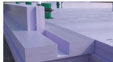
L'emballage complet du radier porteur en béton armé à l'aide de système permet véritablement de se prémunir de tout noeud constructif, tout en conservant le bénéfice de l'inertie thermique du béton du côté du volume protégé. Une fois le béton de propreté exécuté sur l'empierrement, la pose de ce radier isolant a nécessité une petite journée d'intervention. Tous les resserrages autour des gaines techniques traversant le radier isolant ont été soigneusement exécutés.
